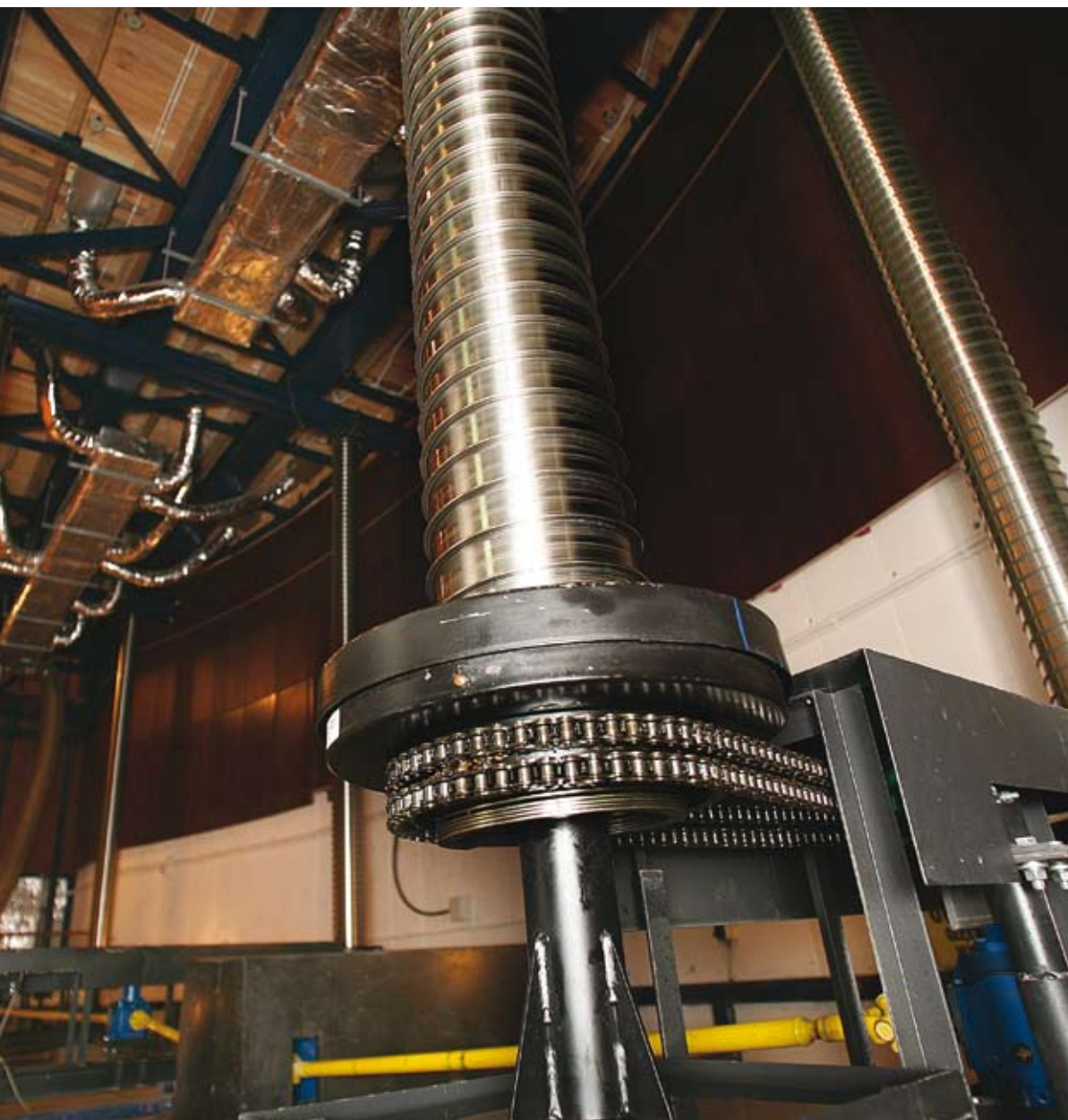
Zdjęcie 34. Zapadnia z napędem spiralift. Opera Wroclawska. Projekt i wykonanie: Przedsiębiorstwo Specjalistyczne TEATR. 2001
