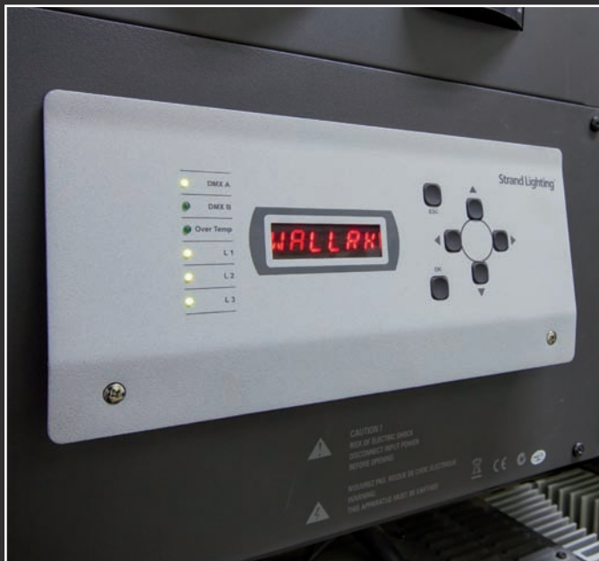
REGULATORY OBWODÓW REGULOWANYCH FIRMY PHILIPS STRAND LIGHTING
