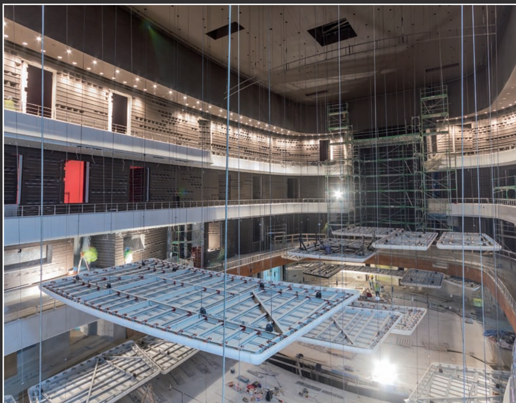
WIDOK NA PANELE AKUSTYCZNE W GŁÓWNEJ SALI KONCERTOWEJ
