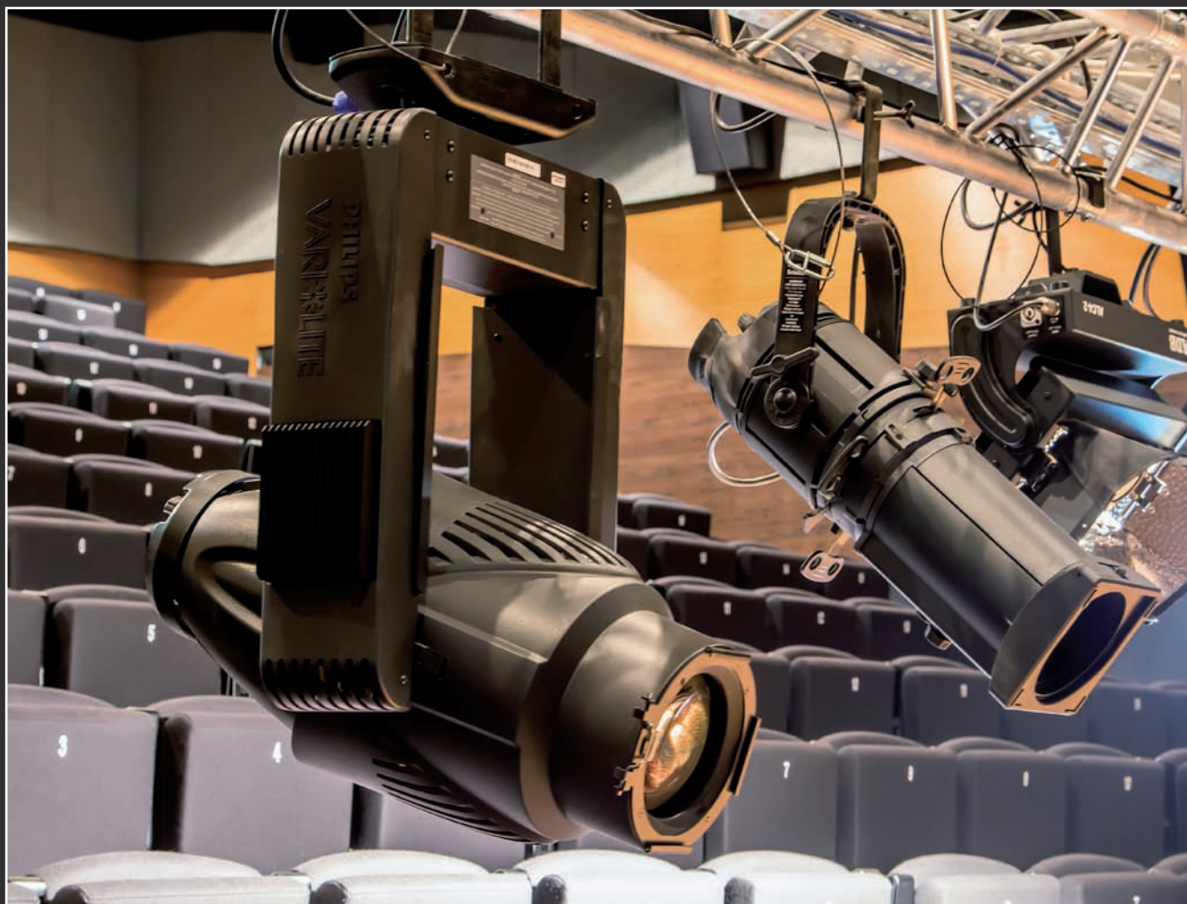
□ OŚWIETLENIE TECHNOLOGICZNE (NA PIERWSZYM PLANIE RUCHOMA GŁOWA FIRMY PHILIPS VARI* LITE I REFLEKTOR FIRMY PHILIPS SELECON)
