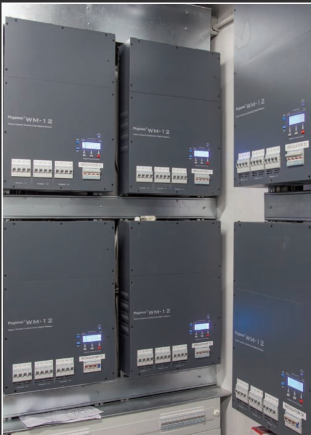
REGULATORY NAPIĘCIA PEGASUS FIRMY PLS
