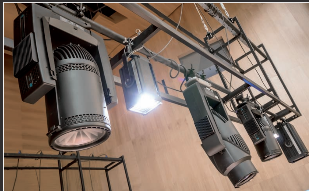
❑ PARK OŚWIEŹLENIOWY - NA PIERWSZYM PLANIE RUCHOME GŁOWY FIRMY PHILIPS VARI*LITE
