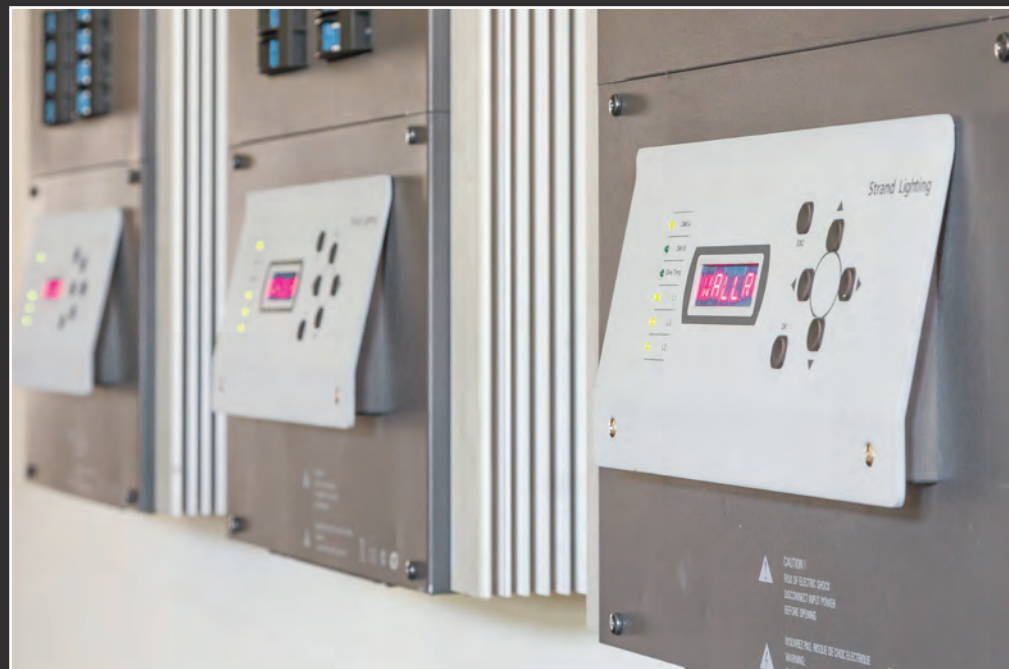
□ CYFROWE REGULATORY NAPIĘCIA WALL RACK FIRMY PHILIPS STRAND LIGHTING
