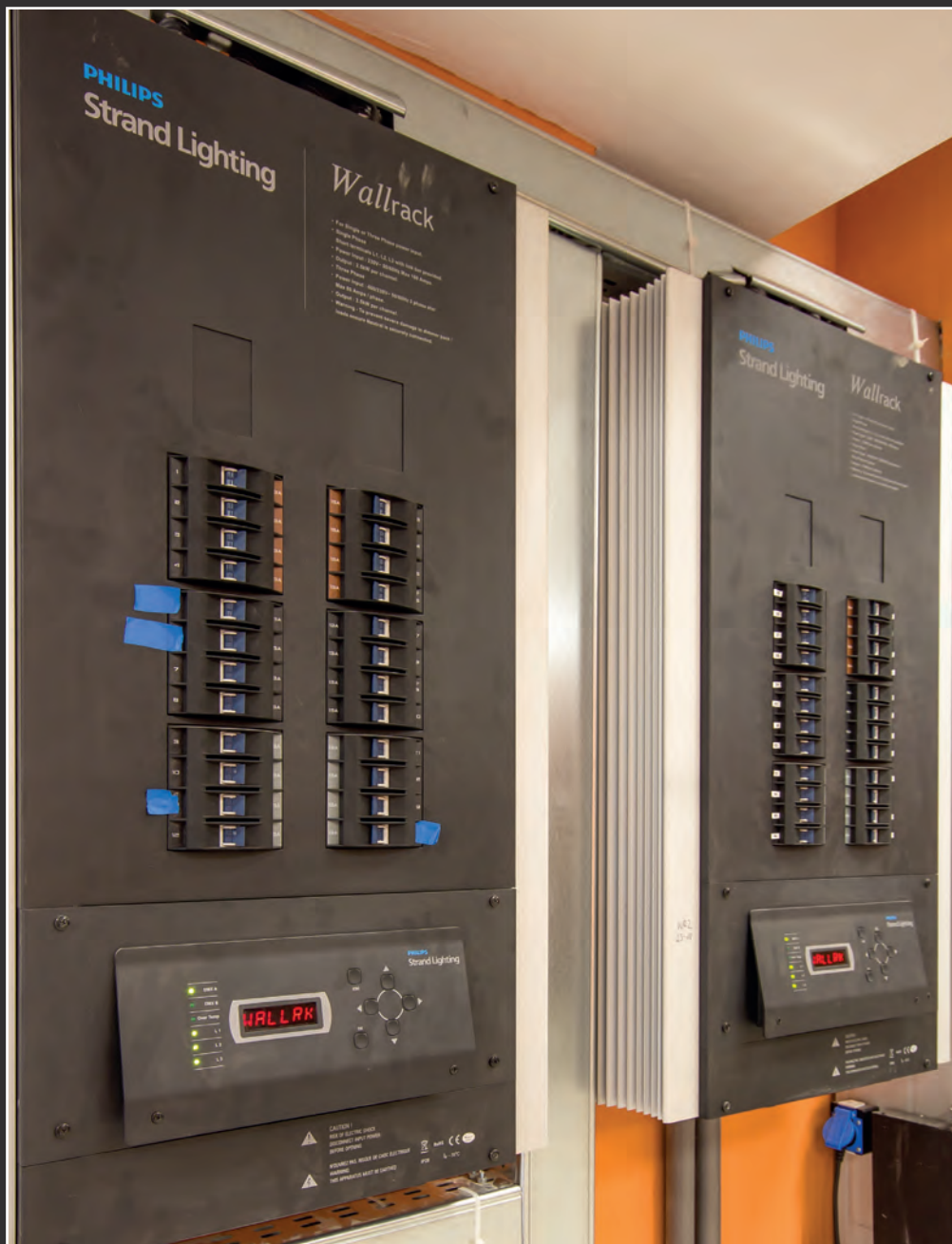
□ REGULATORY NAPIĘCIA WALL RACK FIRMY PHILIPS STRAND LIGHTING
