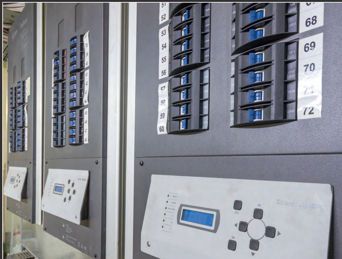
□ CYFROWE REGULATORY NAPIĘCIA WALL RACK FIRMY PHILIPS STRAND LIGHTING
