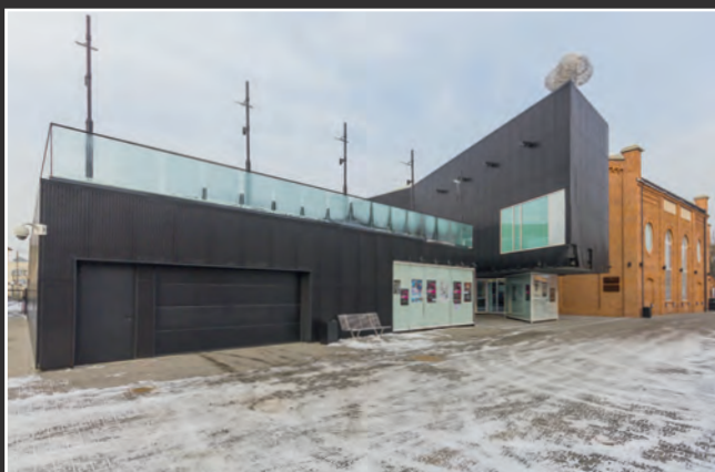
☐ MCSW ELEKTROWNIA W RADOMIU
