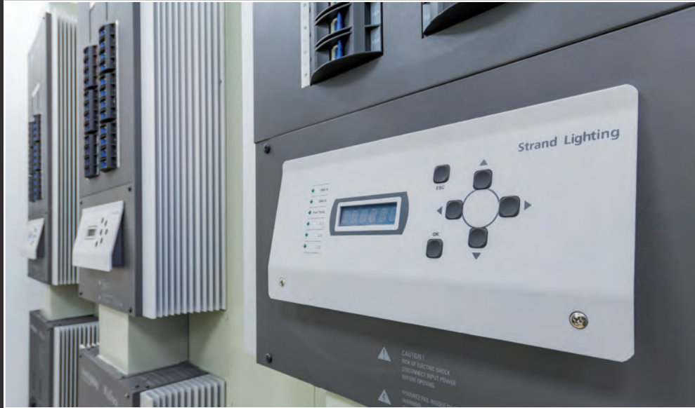
□ REGULATORY OBWODÓW REGULOWANYCH WALLRACK FIRMY PHILIPS STRAND LIGHTING
