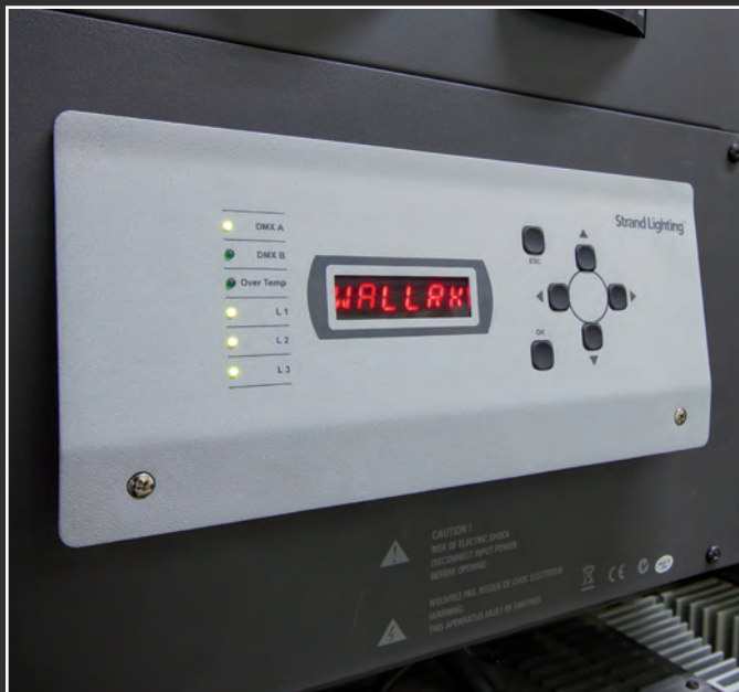
REGULATORY OBWODÓW REGULOWANYCH FIRMY PHILIPS STRAND LIGHTING
